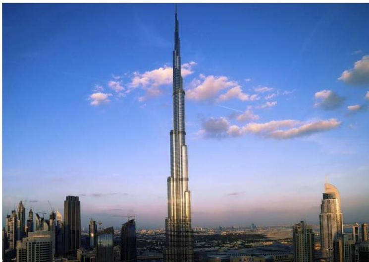
迪拜塔又称迪拜大厦或比斯迪拜塔，是位于阿拉伯联合酋长国的迪拜内，高度为 828 米（2,717 英尺），楼层总数是 169 层，是目前世界第一高楼。建筑设计采用了一种具有挑战性的单式结构，由连为一体的管状多塔组成，具有太空时代风格的外形，基座周围采用了富有伊斯兰建筑风格的几何图形——六瓣的沙漠之花。
